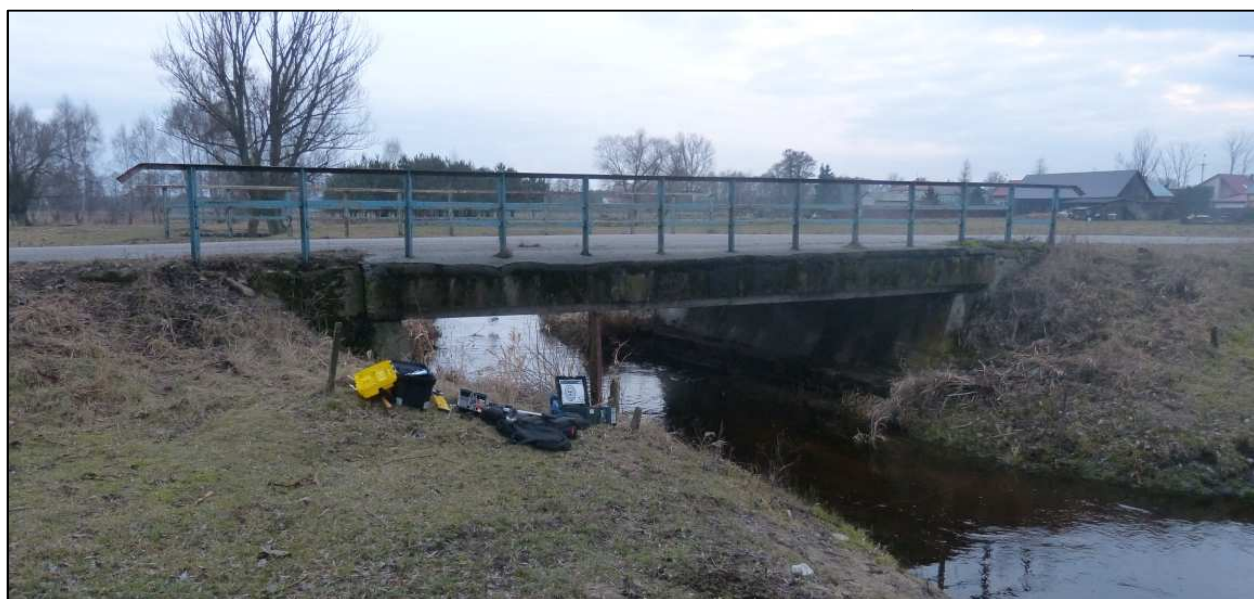
Rys. 2.2 Widok na obiekt od strony wody górnej
